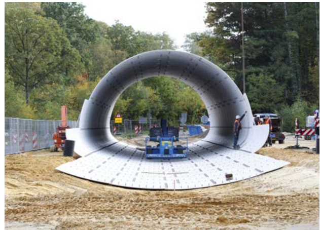
Afbeelding 8. Profilering zandbed
