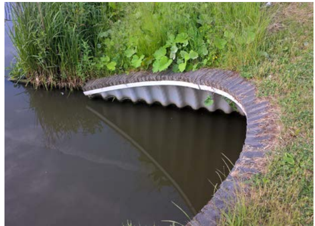
Afbeelding 11. Afwerking met taludrand
