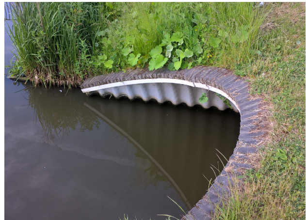
Afbeelding 11. Afwerking met taludrand
