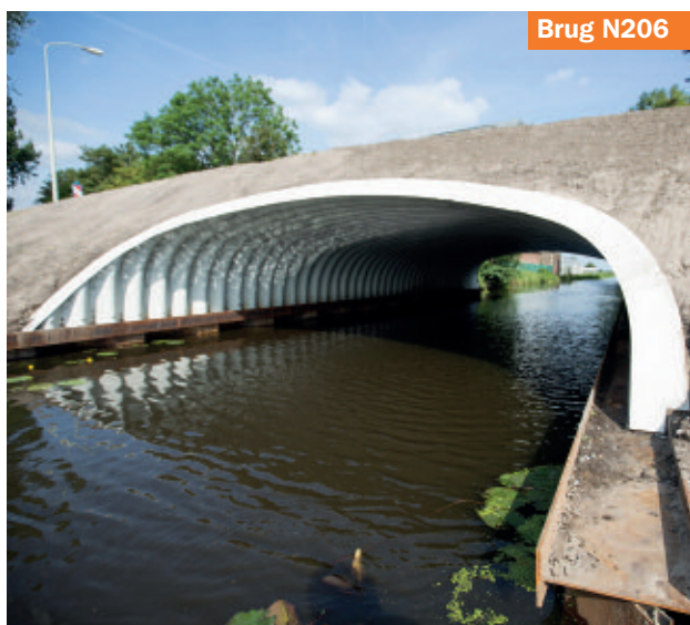
Afbeelding 11. Aansluiting van SuperCor® constructie aan stalen voetplaten van een volledig stalen bodem
