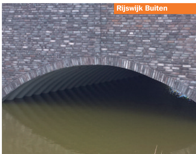
Afbeelding 12. Voorbeeld van een betonrand op de in- en uitgang van de constructie
