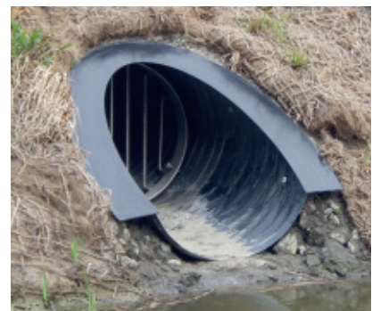
SPIROsol faunapassage A2 Kombos Diameter 1,6 m, lengte 80 m
