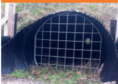
SPIROsol faunapassage A2 Kombos Diameter 1,6 m, lengte 80 m
